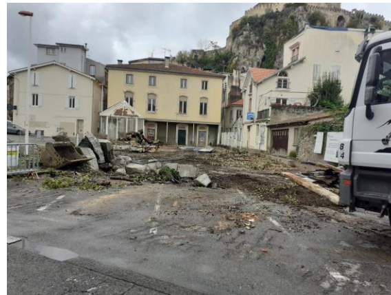
Préparation du terrain - septembre 2023
